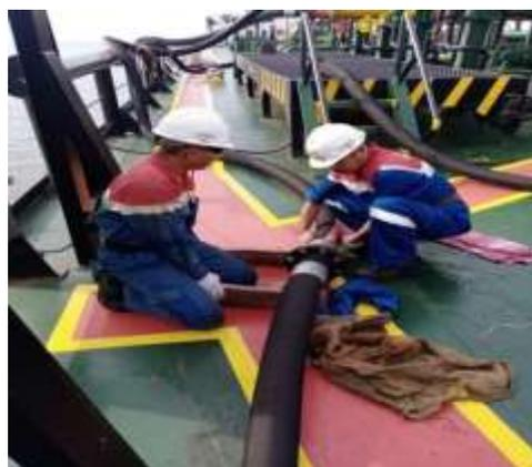
**Gambar 4.** Penyambungan *hose connection*
